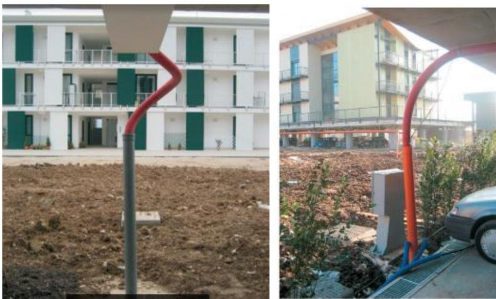
FIG.8 – esempio di disconnessione di cavidotti ( Terremoto L'Aquila 2009)
